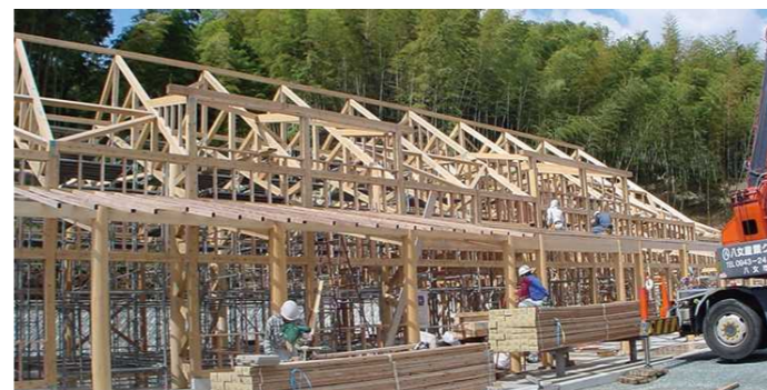
拡張樹脂アンカー工法使用
