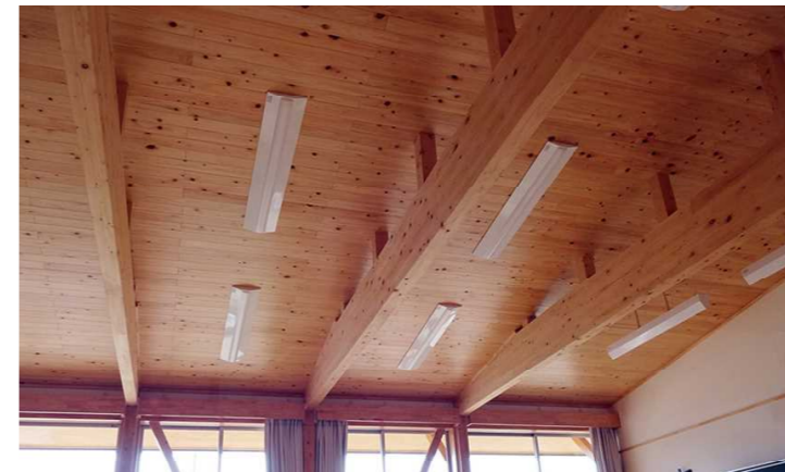
拡張樹脂アンカー工法使用
