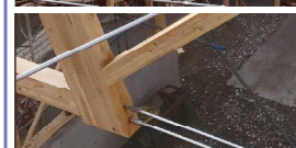
現場での地組は、高ナット、ターンバックル、金物で接合します。
