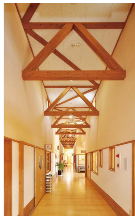
拡張樹脂アンカー工法使用
