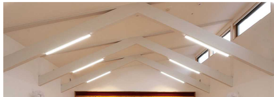
拡張樹脂アンカー工法使用
