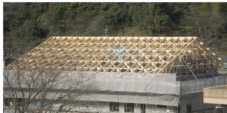
拡張樹脂アンカー工法使用
