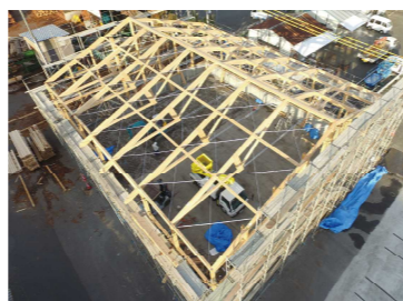
構造: 木造平屋 スパン17.6m 施工面積: 375.5 m 2
