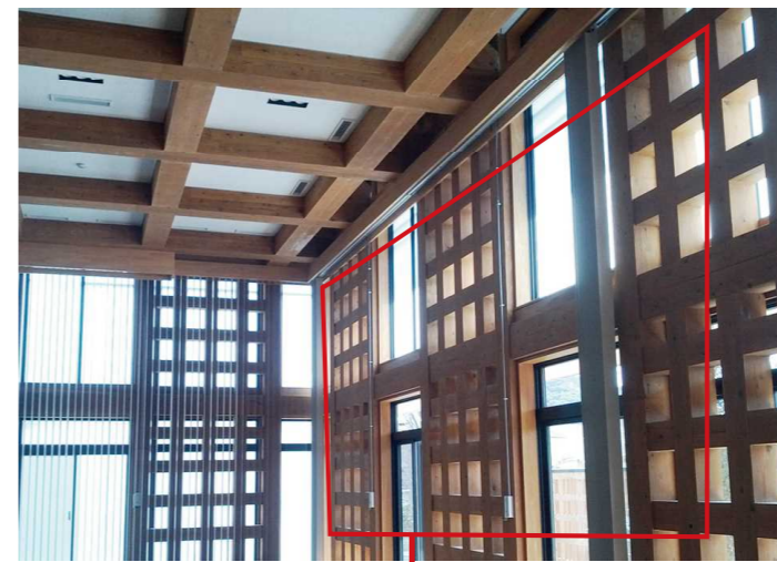
拡張樹脂アンカー工法使用
