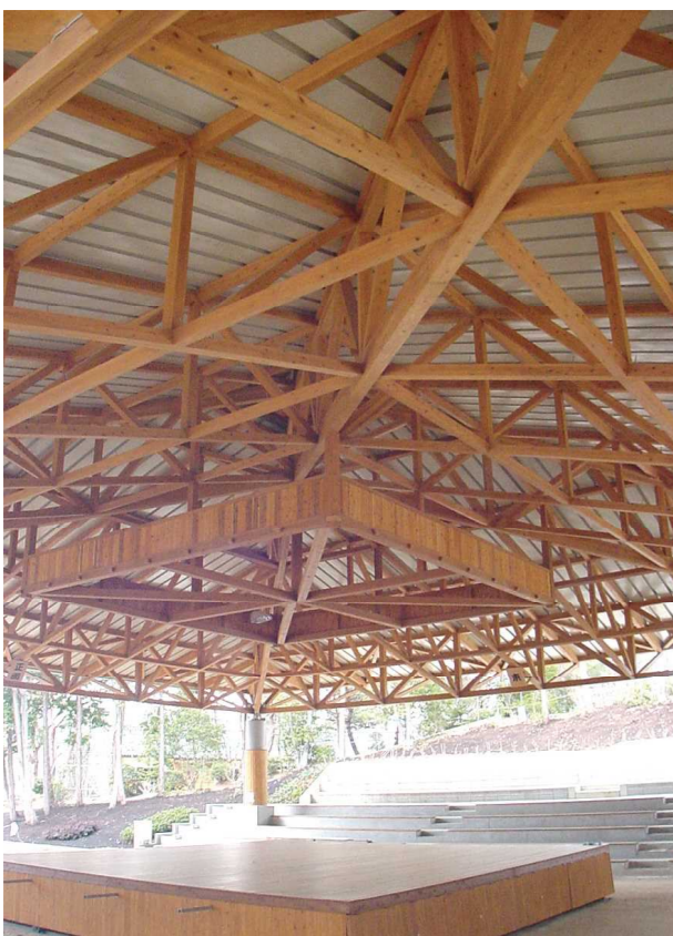
拡張樹脂アンカー工法使用
