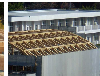
某学校の屋内運動場:木造平屋・軸組まで木造 20×32mスパン ラチスシェル屋根
