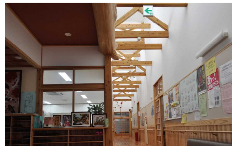
拡張樹脂アンカー工法使用
