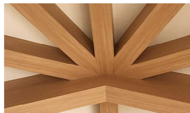
拡張樹脂アンカー工法使用
