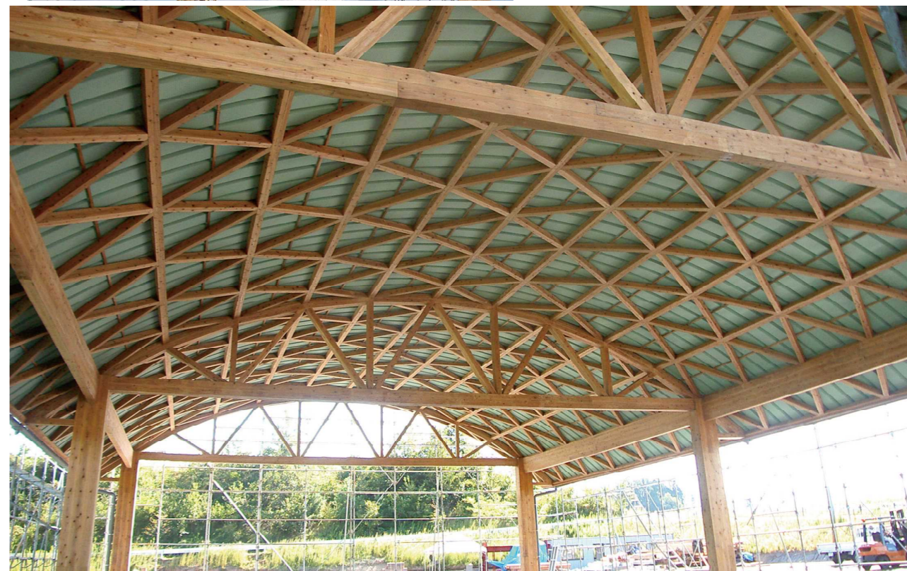
拡張樹脂アンカー工法使用
