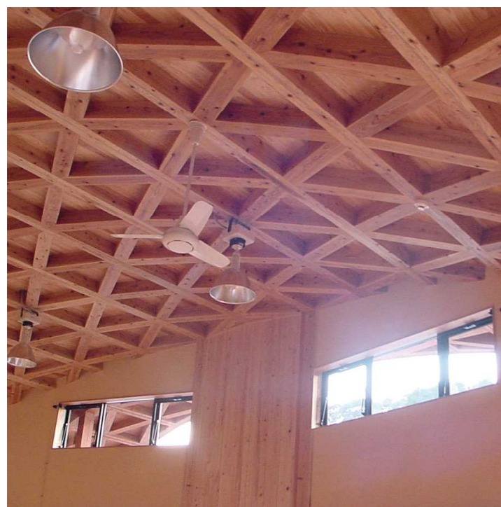
拡張樹脂アンカー工法使用
