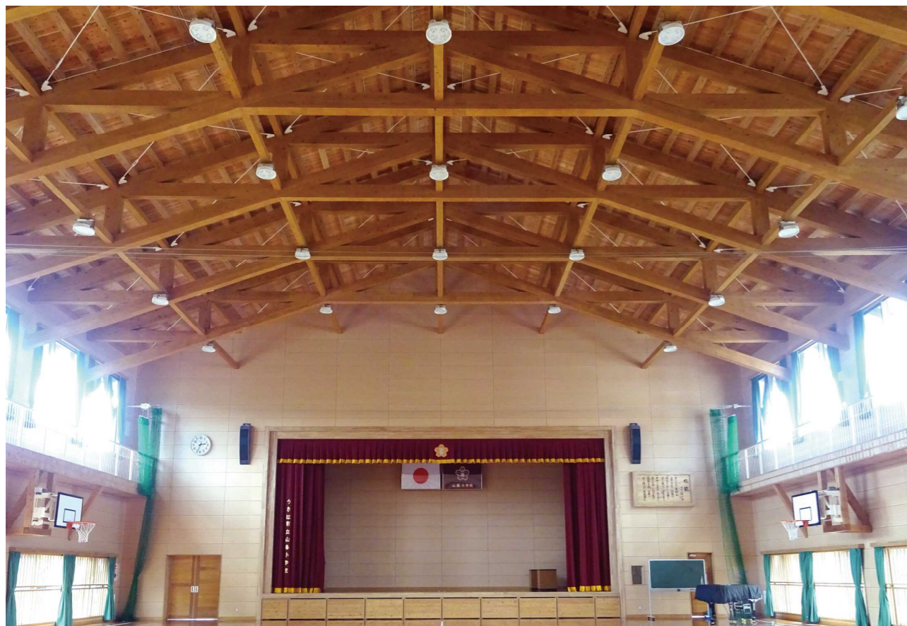
拡張樹脂アンカー工法使用
