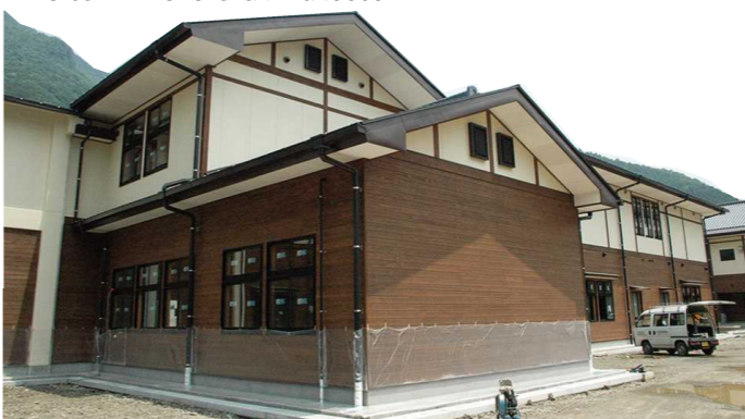
拡張樹脂アンカー工法使用
