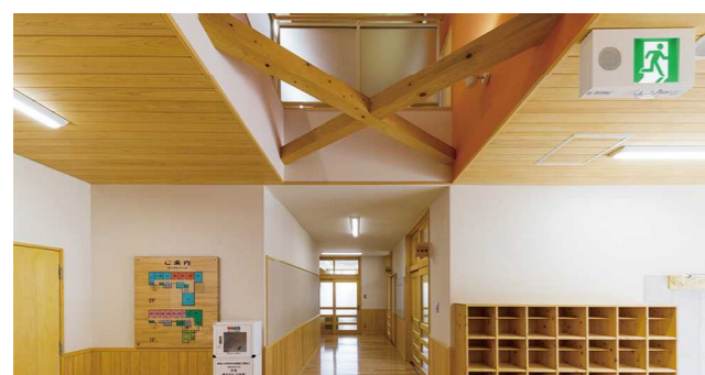
拡張樹脂アンカー工法使用
