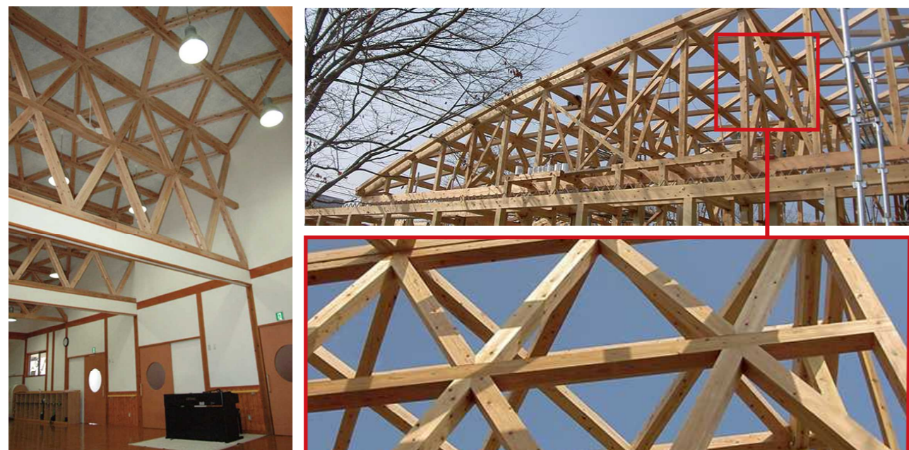
拡張樹脂アンカー工法使用
