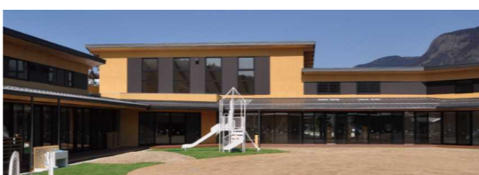
拡張樹脂アンカー工法使用
