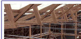
工場組立・現場搬入トラス トラスは、搬入サイズまでは組み立てた状態で納品します。
