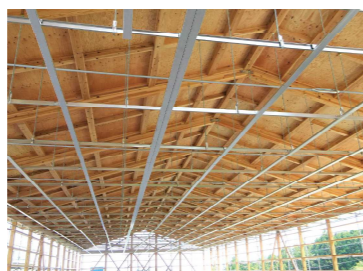
構造: 木造平屋 スパン10m 施工面積: 322 m 2
