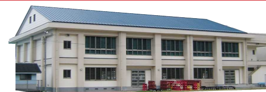
拡張樹脂アンカー工法使用
