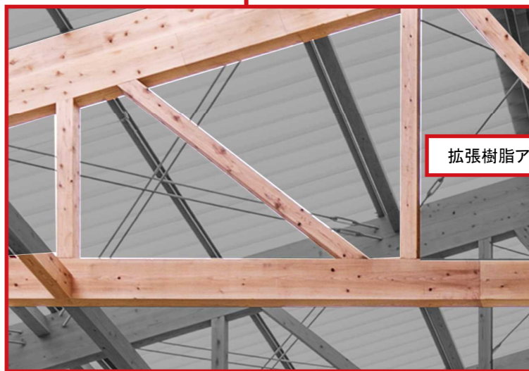
小屋繋ぎ梁：ウッドファスナー工法使用
