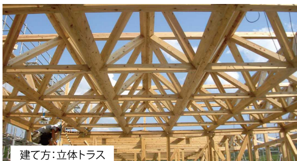
建て方：立体トラス
