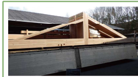
工場組立・現場搬入トラス トラスは、搬入サイズまでは組み立てた状態で納品します。
