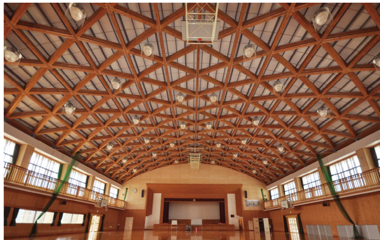
拡張樹脂アンカー工法使用
