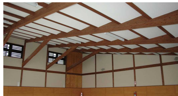
拡張樹脂アンカー工法使用
