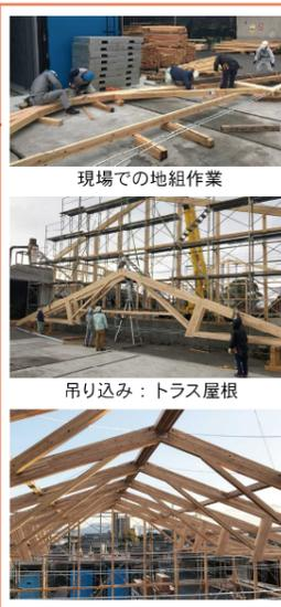
MTトラス使用の倉庫例 (施工実績写真)
