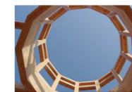
樹脂アンカー継手の引っ張り及び、曲げ耐力により 45 度の格子梁組とした構造で、断面 150×300 の梁を、格子状 2m ピッチに格子梁組されています。
