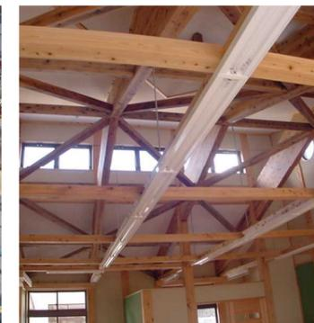
拡張樹脂アンカー継手による合成梁です。
