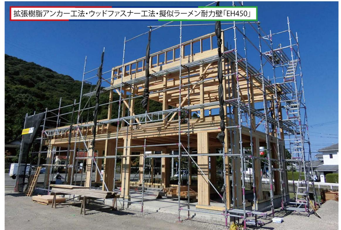
拡張樹脂アンカー工法・ウッドファスナー工法・擬似ラーメン耐力壁「EH450」
