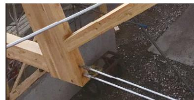
現場での地組は、高ナット、ターンバックル、金物で接合します。
