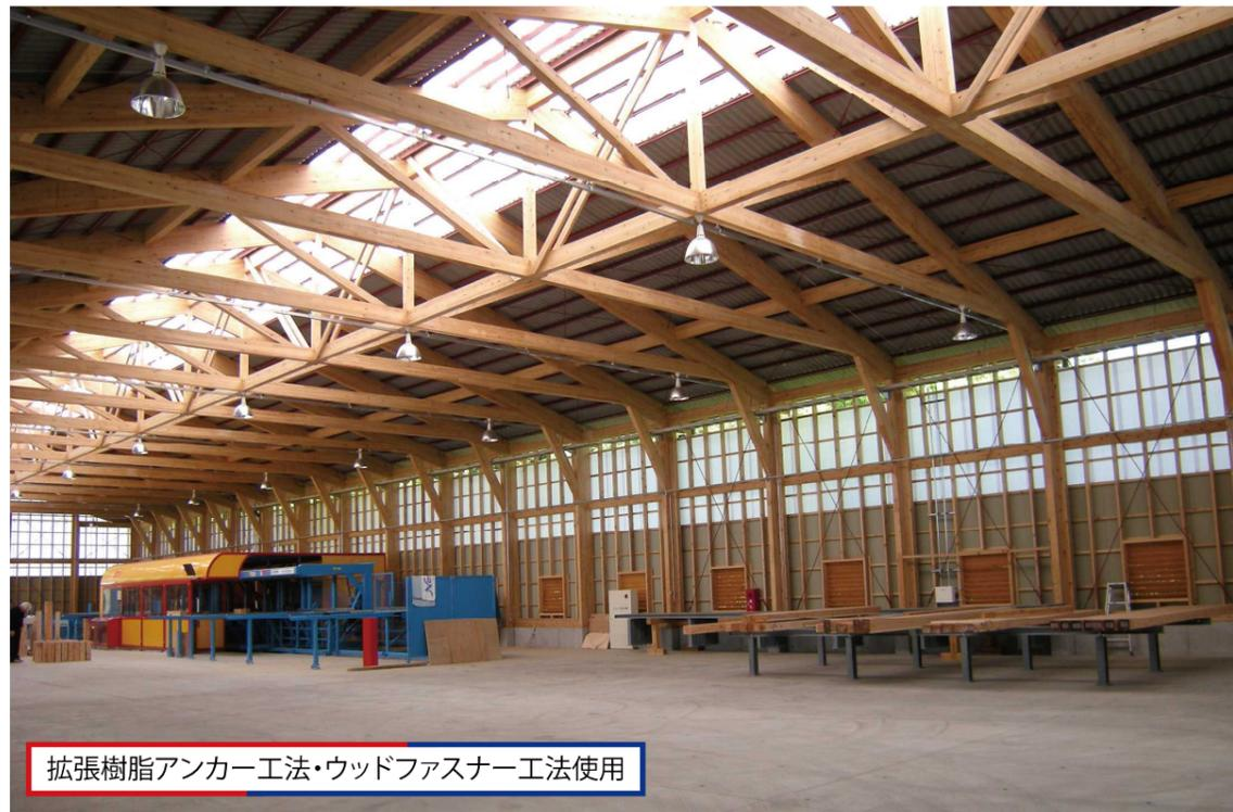
拡張樹脂アンカー工法・ウッドファスナー工法使用
