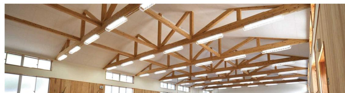
29m×14mの武道場をキングポストトラスで飛ばした構造です。木材は150角を中心に、地元材で構成した武道場です。
