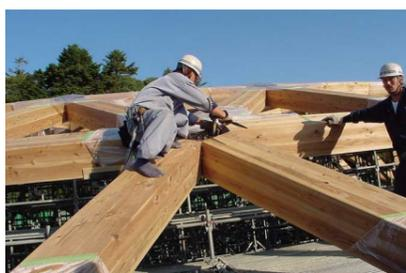
180角木材4本を樹脂により、圧着し鉄板挟み込みとしたハイブリットシェル構造です。
