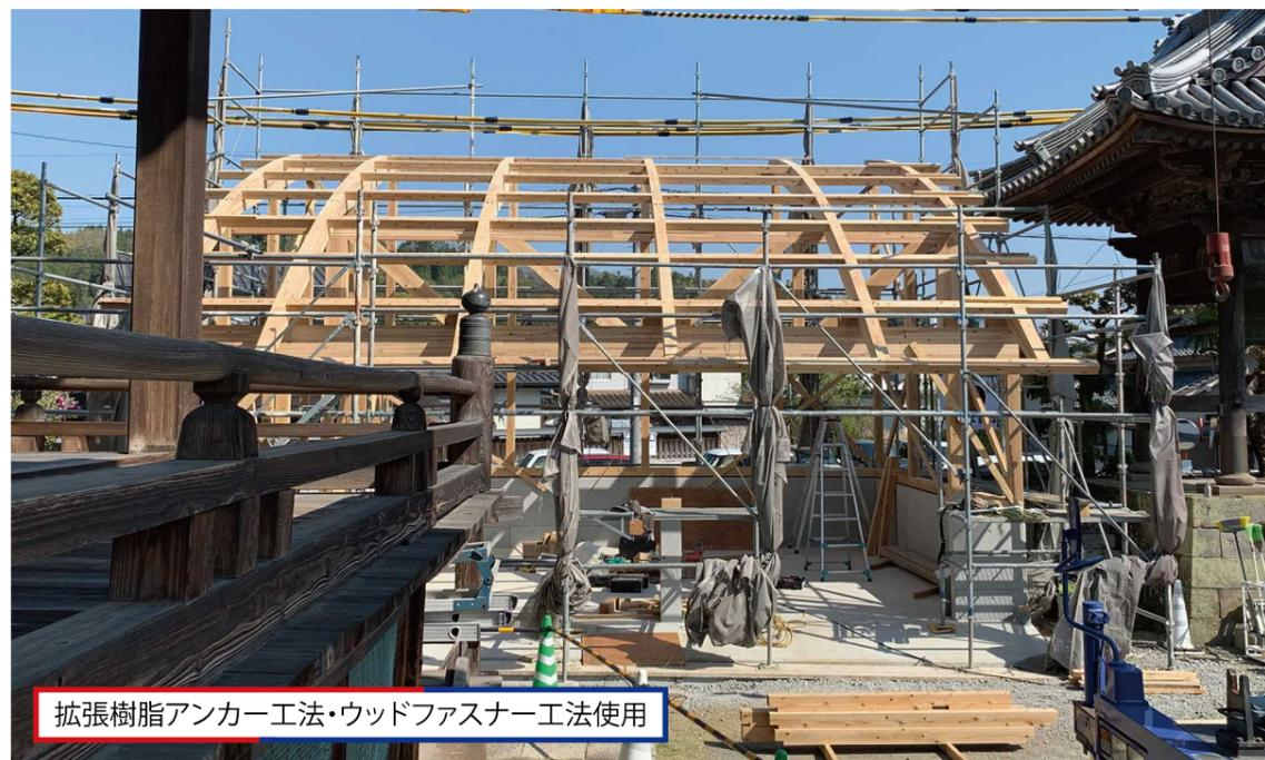
拡張樹脂アンカー工法・ウッドファスナー工法使用
