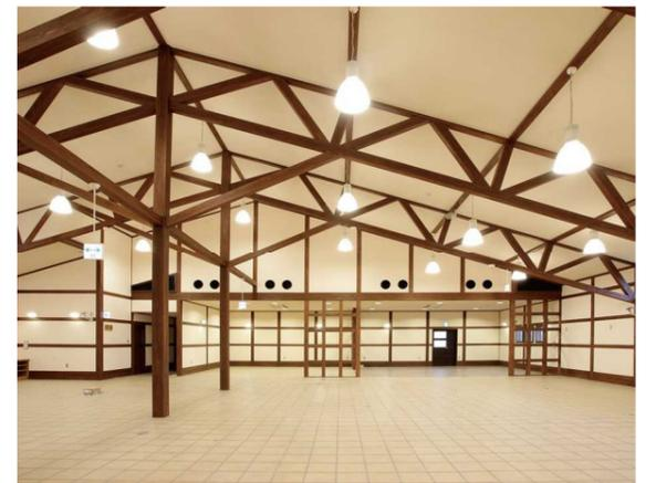
15m×18mの大空間に、約11mのトラスを掛け屋根組を構成した構造です。
