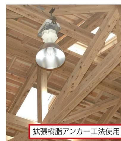
長崎県産材の杉を使用し、土俵のある空間のスパンを9mをキングポストトラスで飛ばした構造形式です。トラスの中心が棟部となり片側がその勾配で低くなる切り妻屋根形状になっています。
